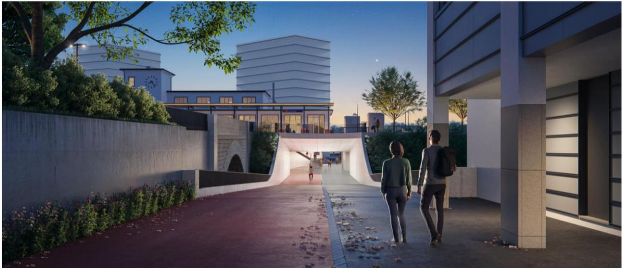
Abb. 10 Visualisierung der Brücke Dünnern mit baulich getrennten Rad- und Gehwegen, im Hintergrund die Hochhaus-Silhouetten nach neuem Gestaltungsplan. Bogenförmige Portale nehmen Bezug auf die bestehende Rundbogenbrücke.
