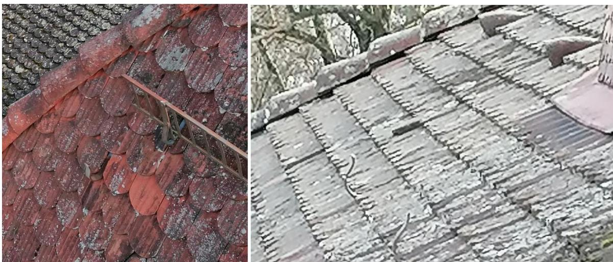
Bei Übergängen von First- zu Gratziegel fehlen Bleilappen, usw.
