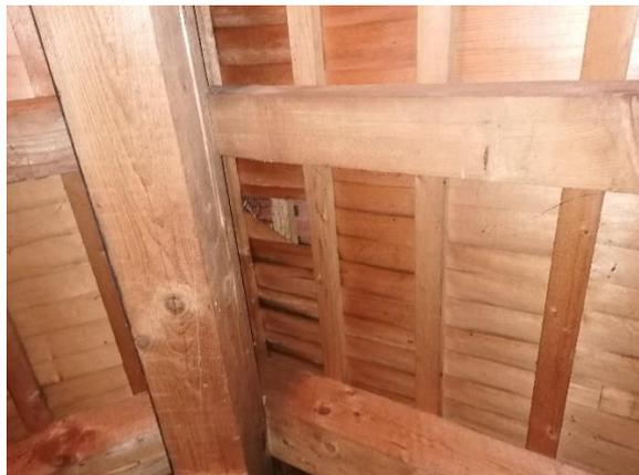
Am Unterdach aus Holzfaserplatten sind Spuren von Urin und Kot von Mardern sichtbar.
