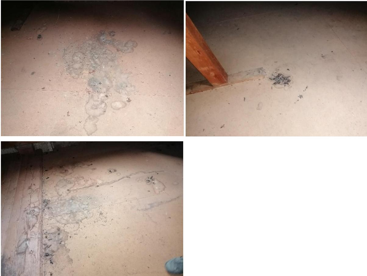
Wir gehen davon aus, dass die Isolation im Deckenbereich von Mardern beschädigt worden ist.
