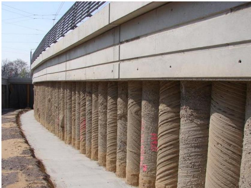
Abb: Unverkleidete Pfahlwand mit sichtbaren Bohrpfehlen und Beton-Pfahlkopfriegel
