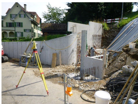
Gartenstützmauer, Hinterer Steinacker
