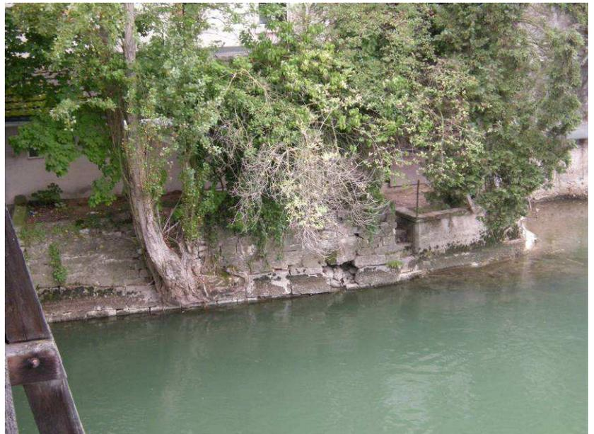
Im **Chessiloch** sind die **Stahlprofile der Spundwand**, welche das Ufer vor dem Ausspülen sichert und den betonierten Uferweg trägt, ebenfalls gerostet. Es soll untersucht werden, wie stark der Rost in die Stahlprofile eingedrungen ist und ob diese Spundwand ersetzt werden müssen.
