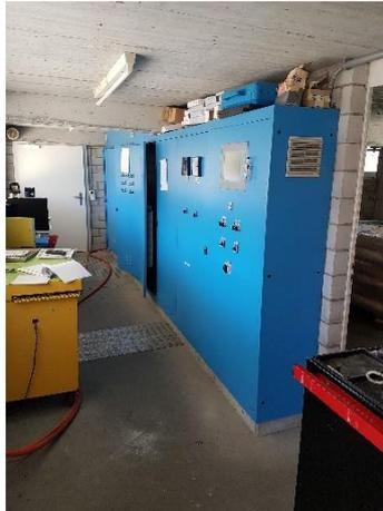
Abbildung 7: Schaltschrank mit SPS
