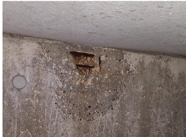
Abbildung 5: Ausgleichsbecken mit Einstieg    Abbildung 6: Betonabplatzungen im AGB
