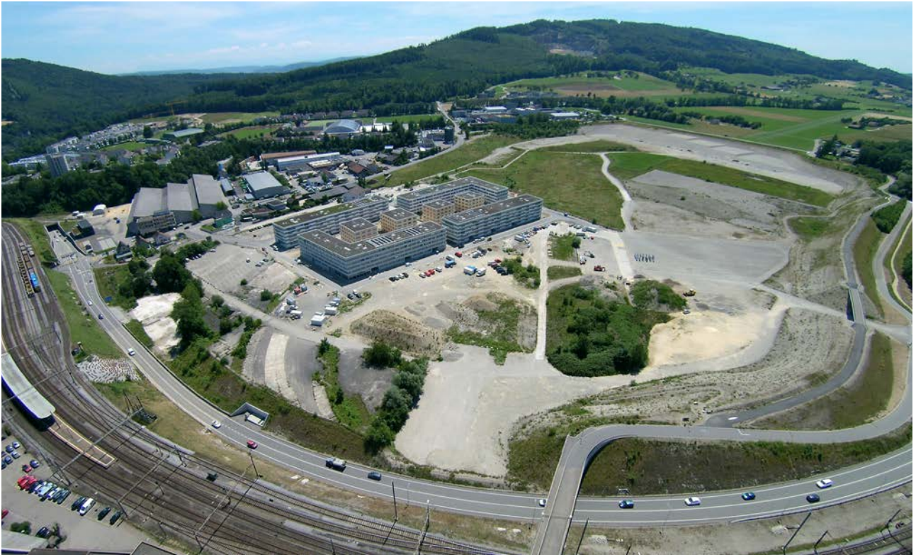
Luftbild Richtung Süden
