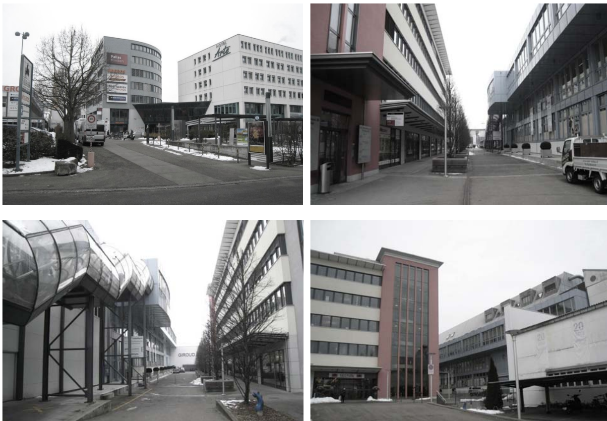
Abbildung 1 Bestehende Situation im Sälipark Areal [Stand: Februar 2015]
